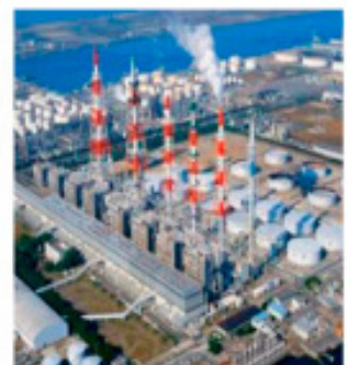
Estação de energia
